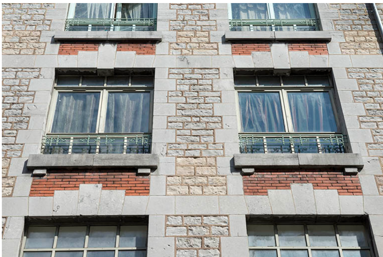
Détail de la façade.
