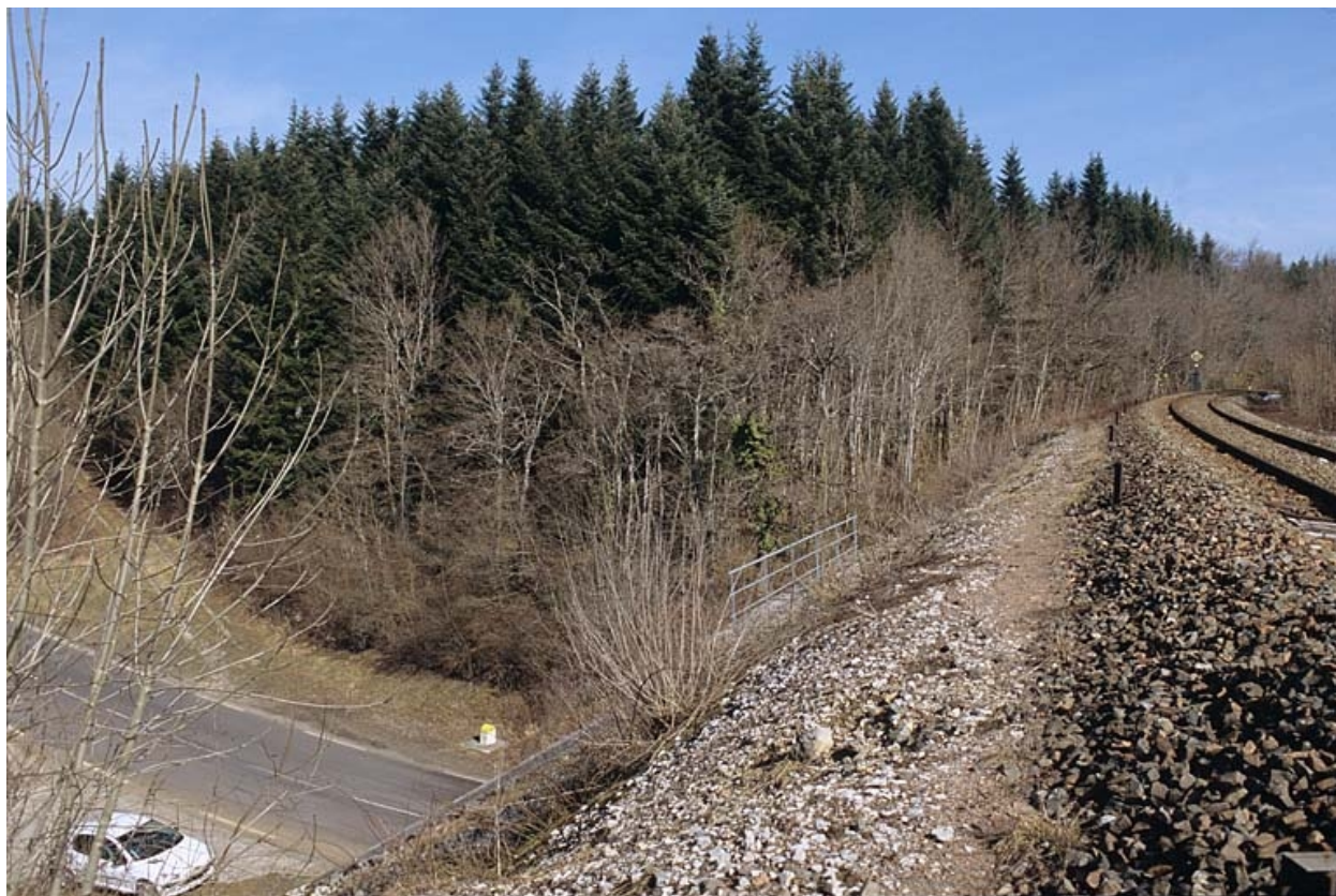
Plate-forme, depuis la voie côté La Cluse.
