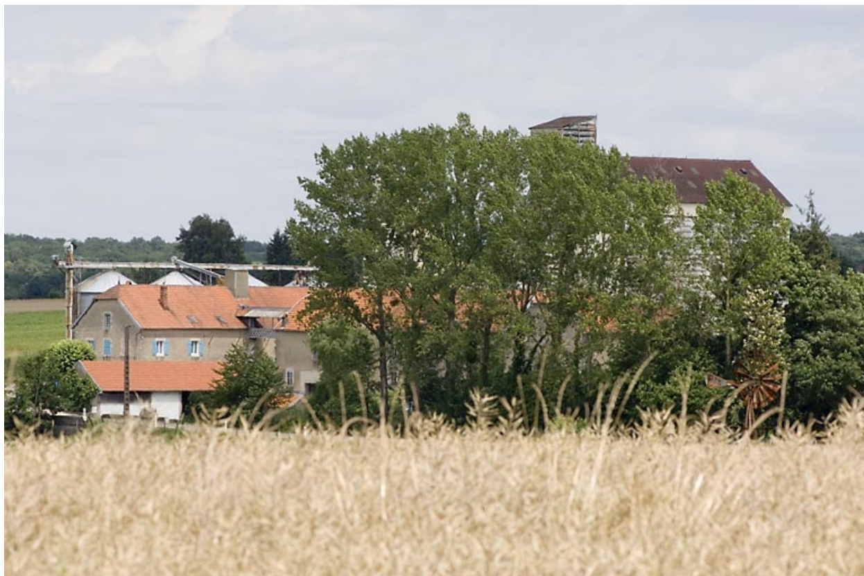
Vue rapprochée depuis le sud-ouest.
