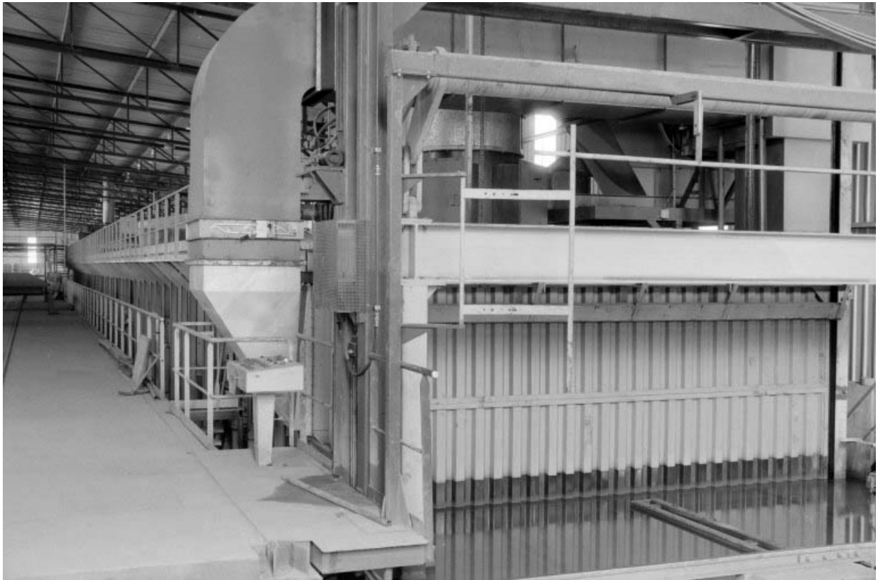
Atelier (M) : four à bassin.
