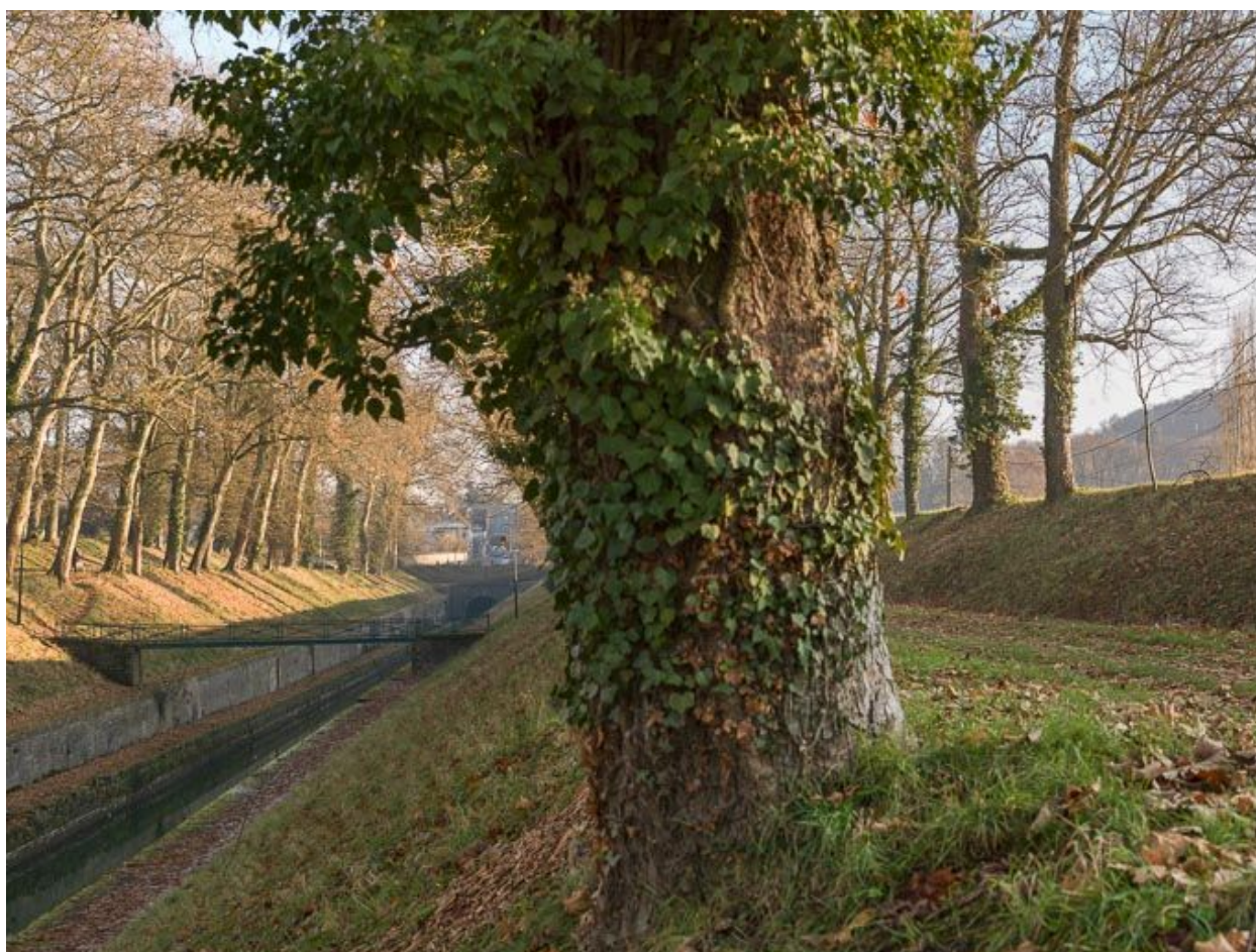
Vue de la tranchée avec la passerelle.
