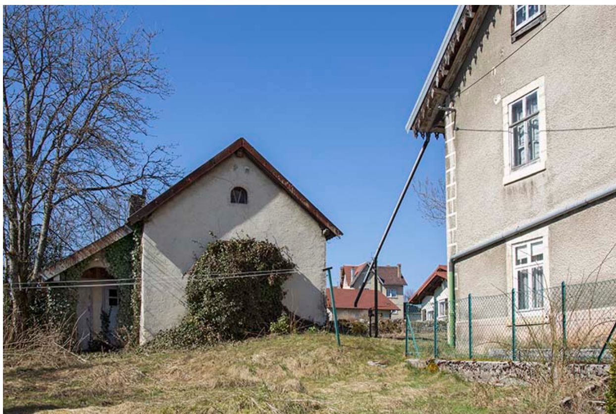
Tuyau d'alimentation de la citerne et dépendance.
