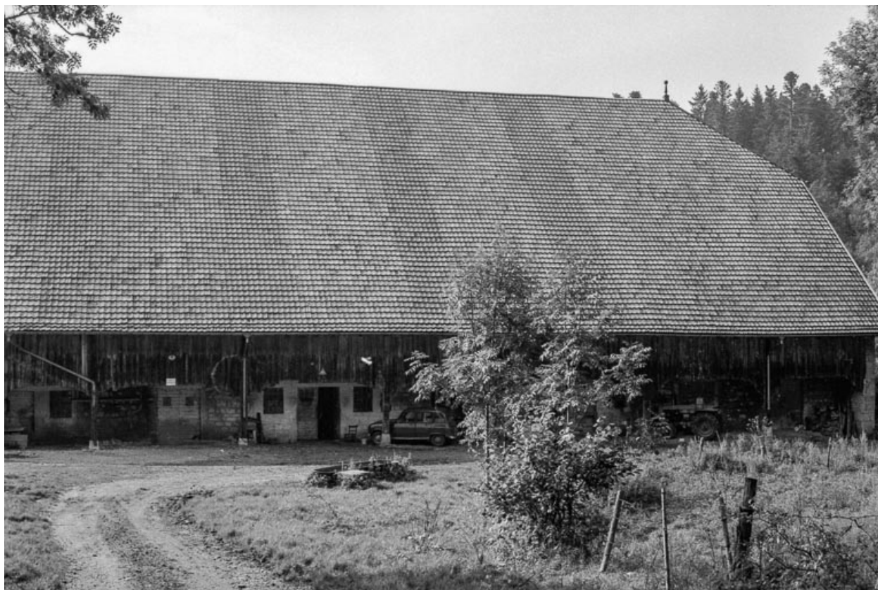
Façade latérale droite.
