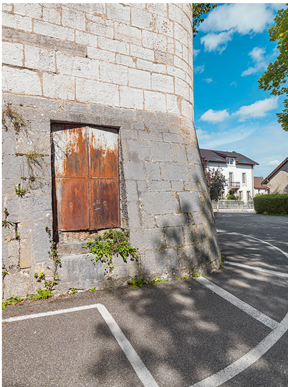
Poterne du demi-bastion.
