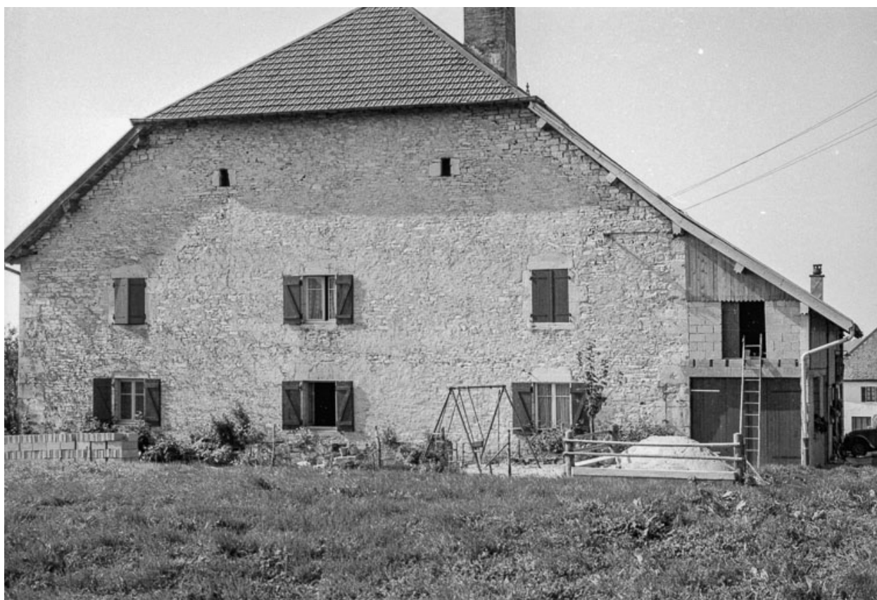
Ferme cadastrée 1961 AB 42 : façade antérieure.
