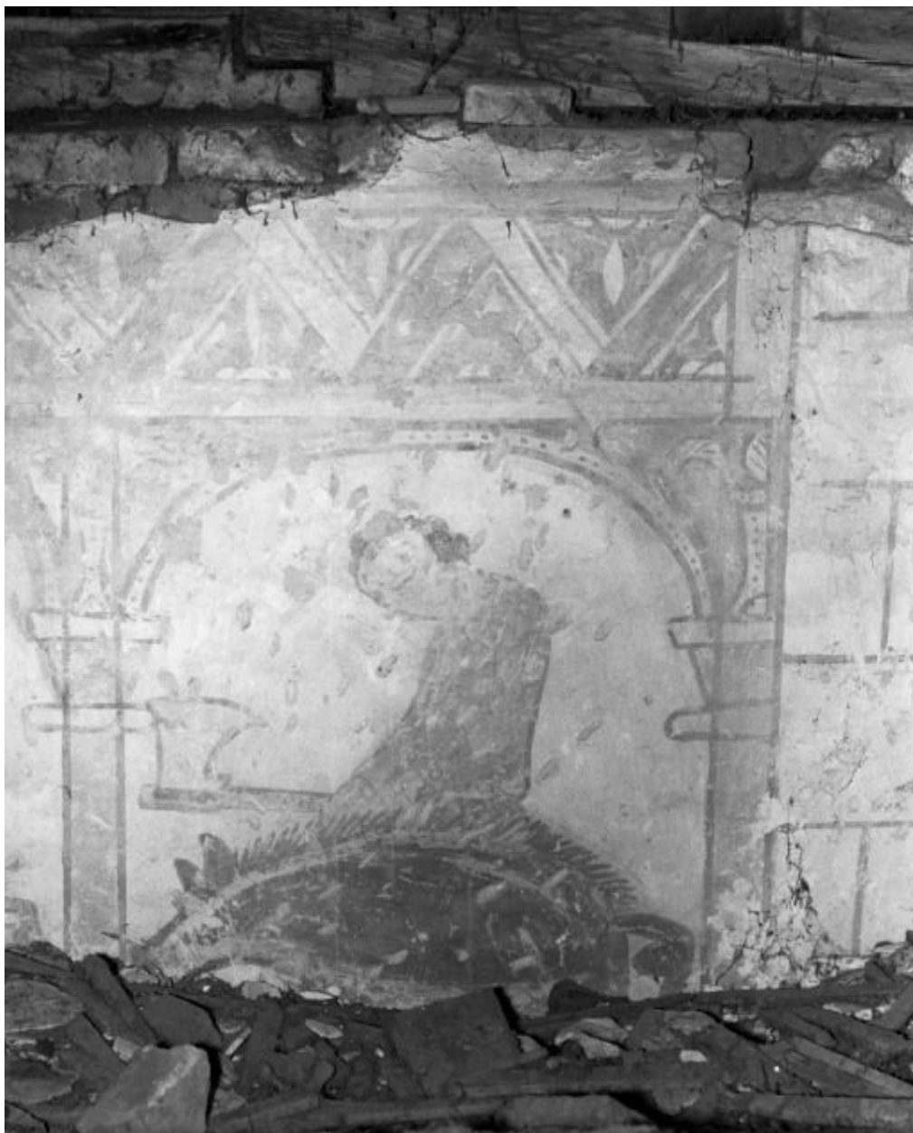
Comble de la nef, mur droit : décembre
