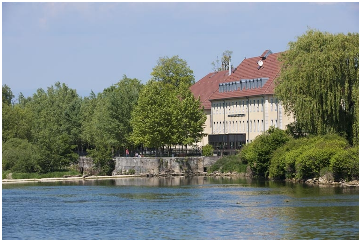
Vue d'ensemble depuis l'amont.
