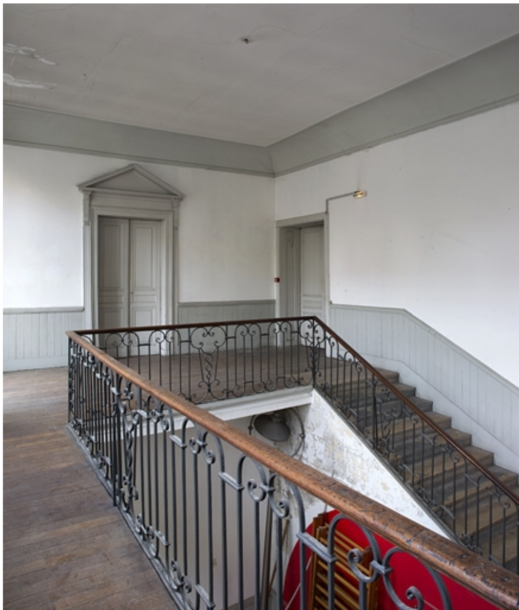
Logis principal, intérieur : vue d'ensemble de l'escalier.
