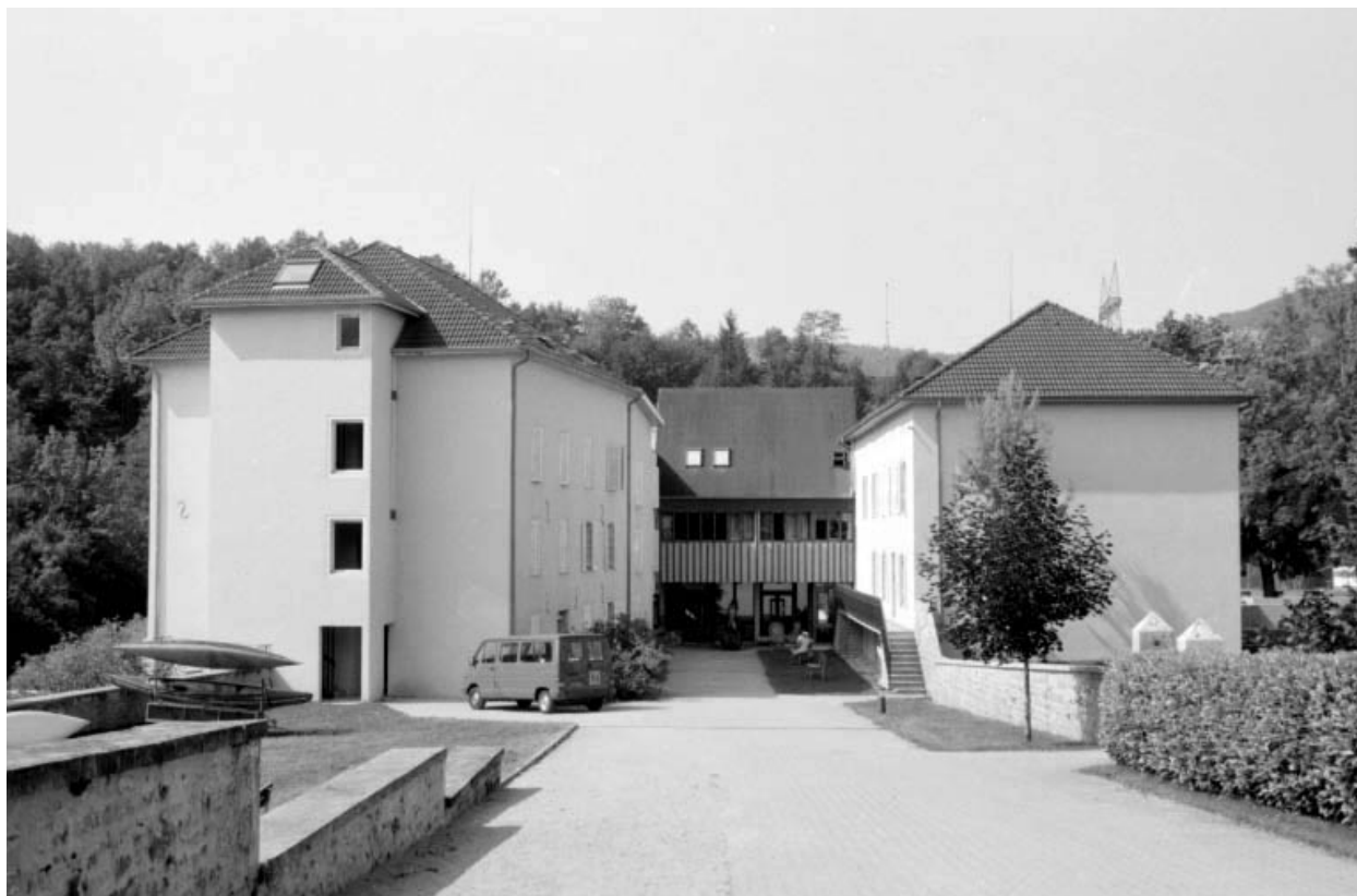
Atelier de fabrication et logement patronal.
