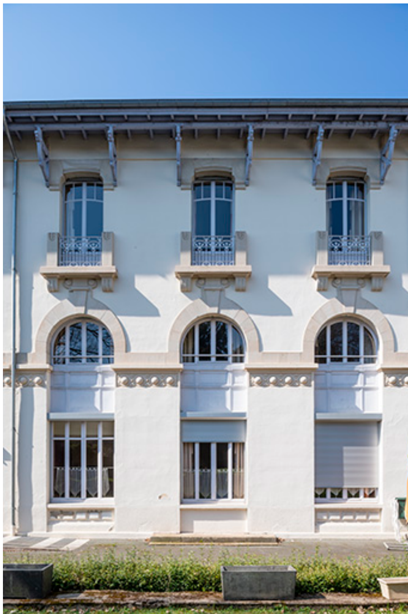
Façade est, vue de face, détail.
