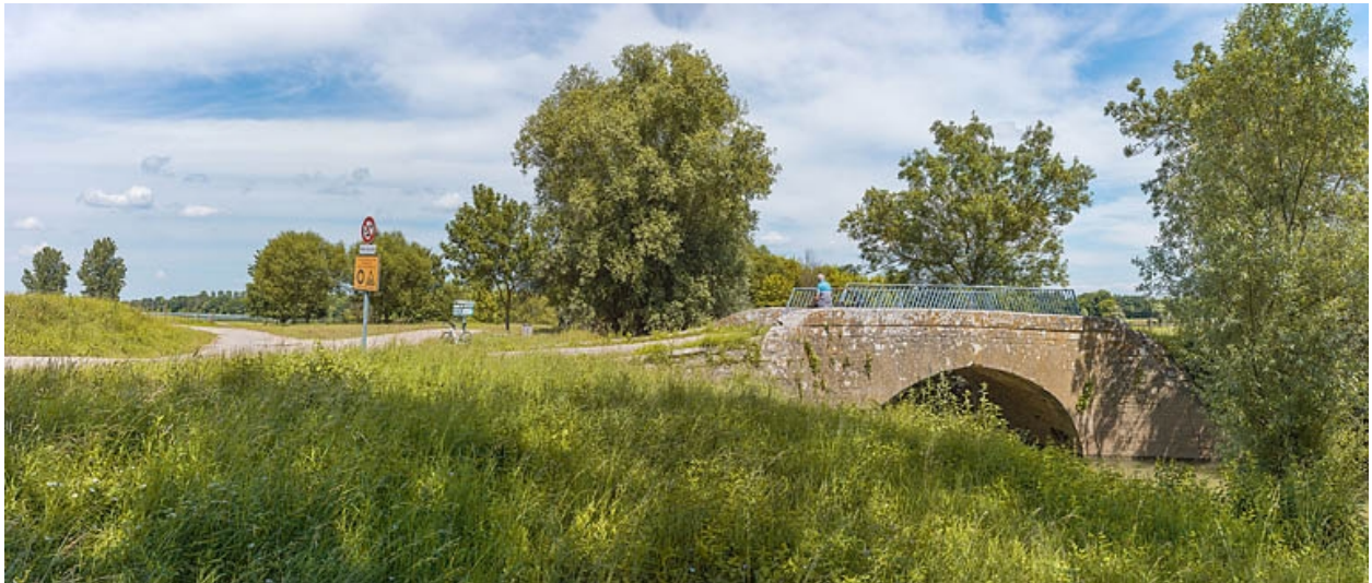
Le pont sur la Mouge, rive droite.
