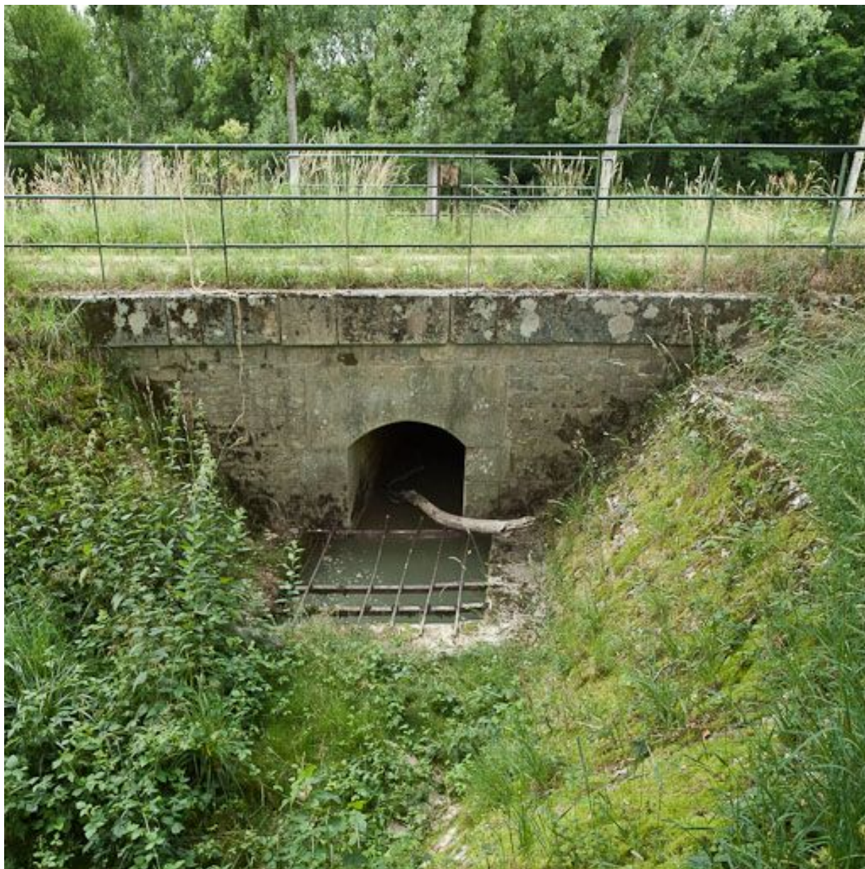
Vue de l'aqueduc.
