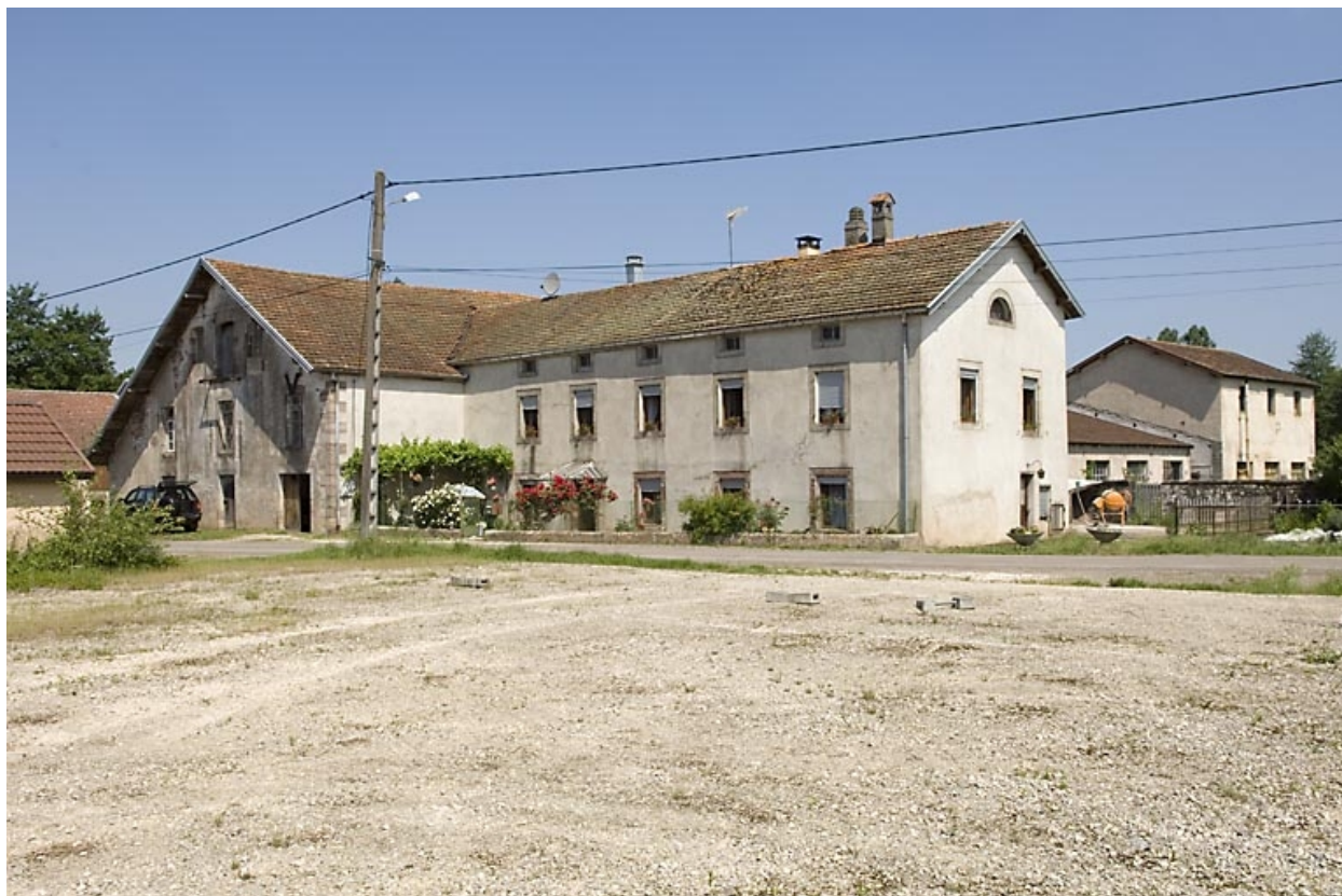
Vue d'ensemble depuis le sud.
