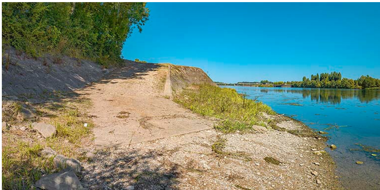
Rampe et perrés de la Mare-Jandeau.
