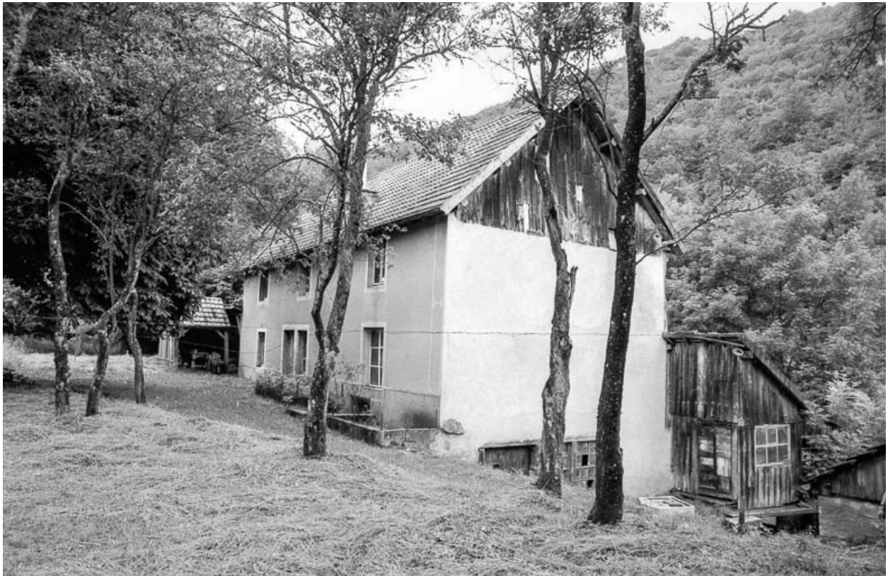
Vue d'ensemble depuis le sud-est en 1980.
