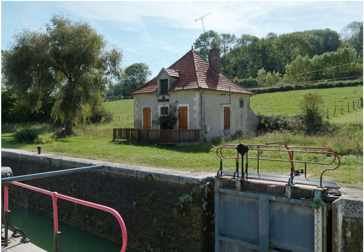
Vue d'ensemble du site d'écluse.
