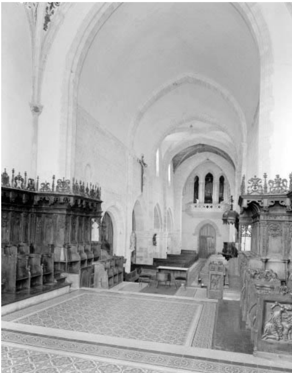
Nef de l'église, vue depuis le chœur.
