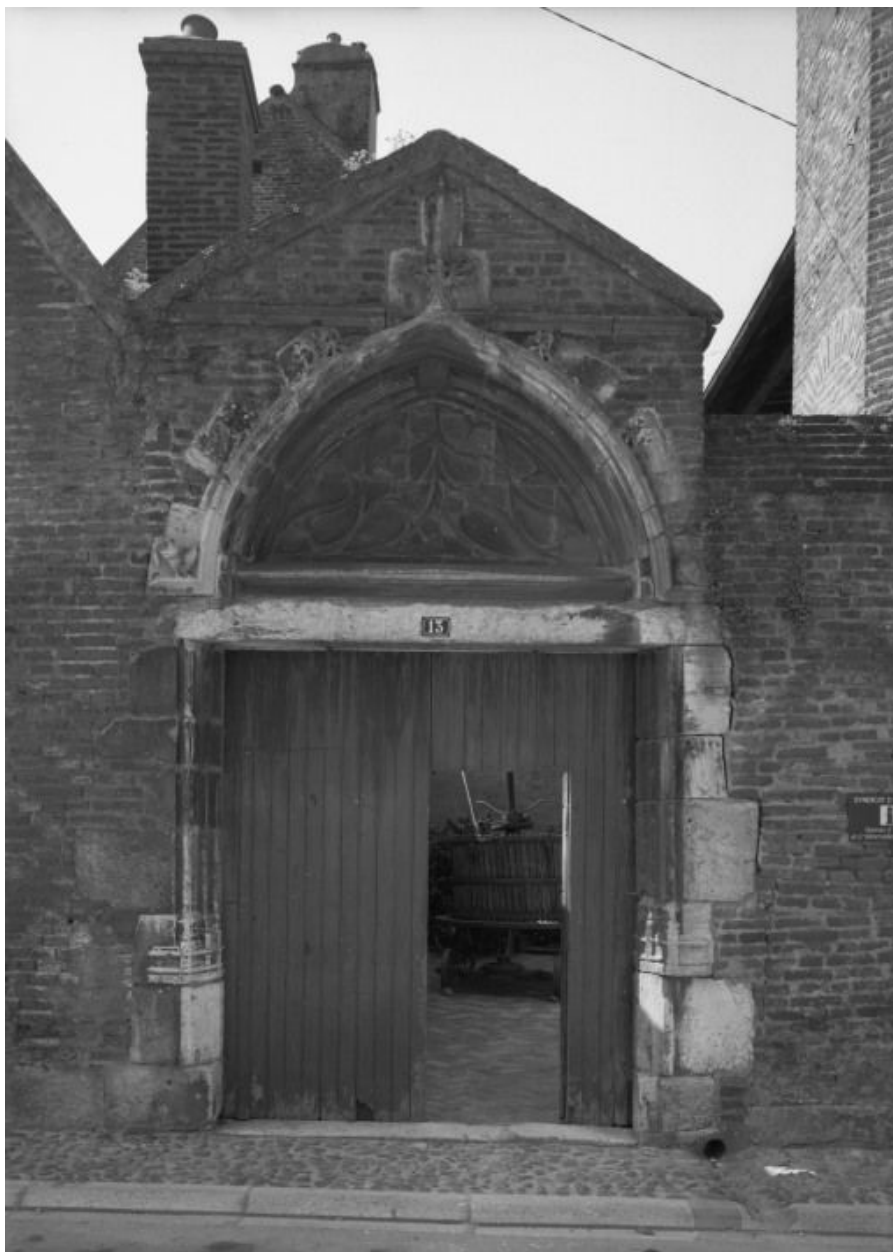
Portail de la cour intérieure.
