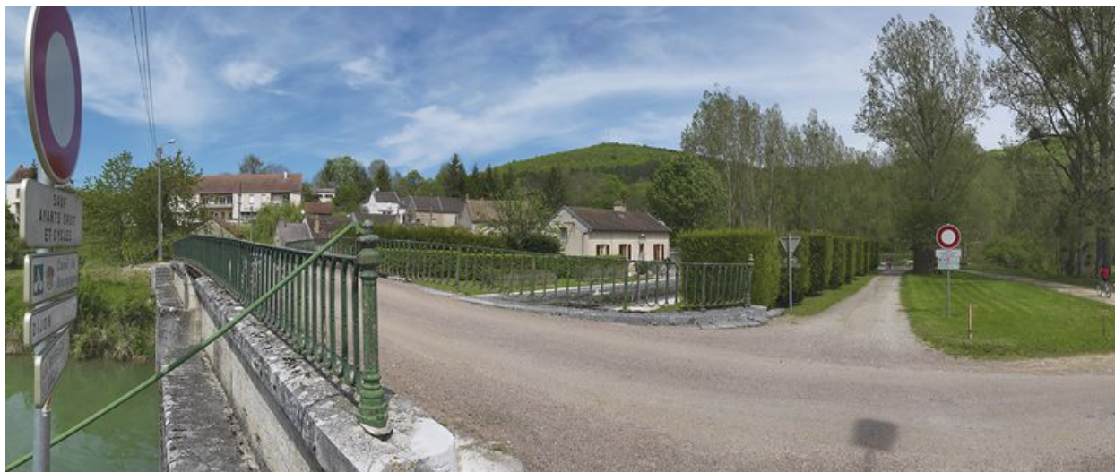
Pont vu d'aval.
