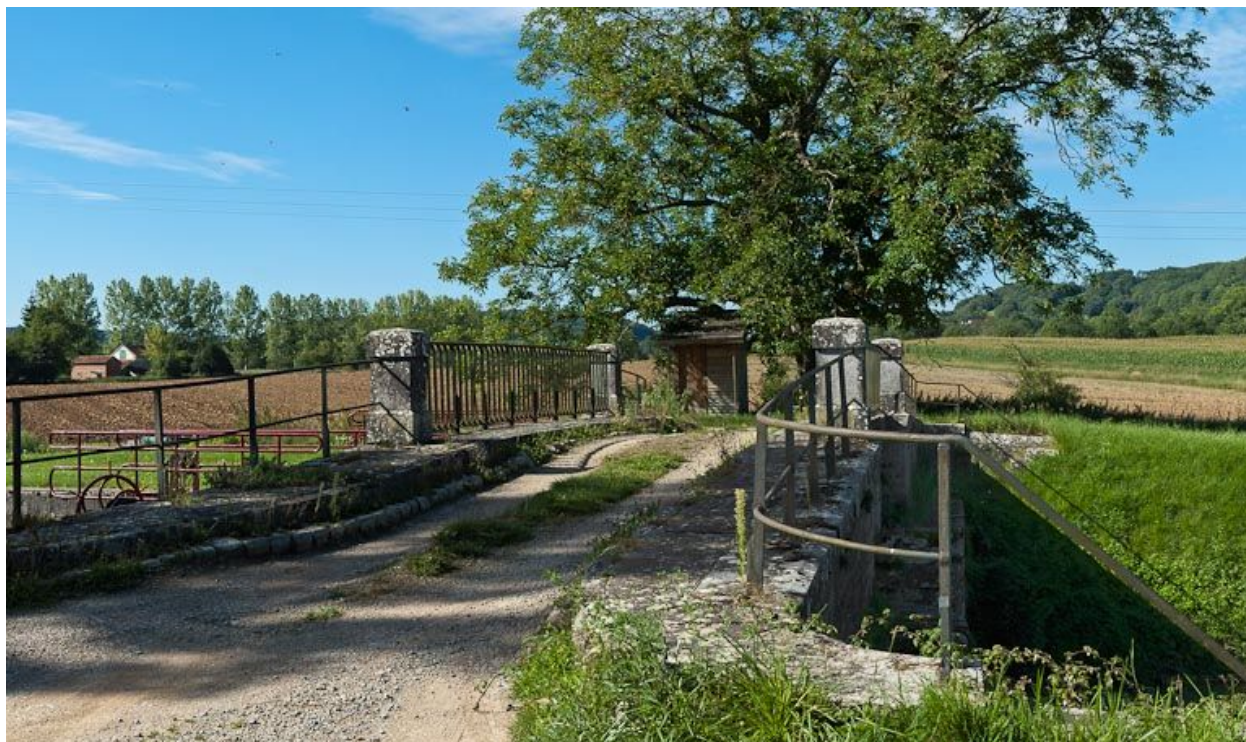
Vue du pont.
