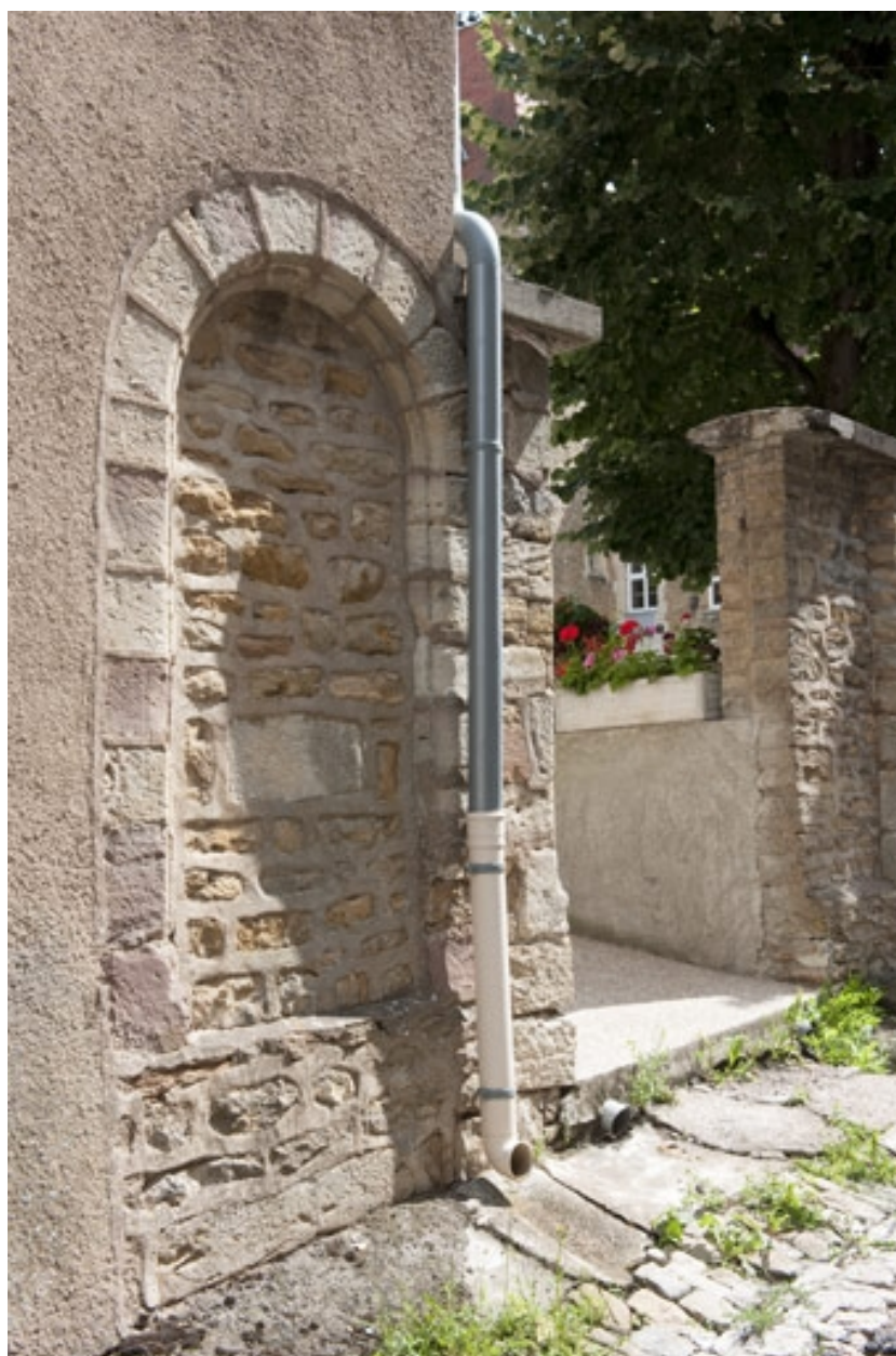
Bâtiment (B), ancienne porte.
