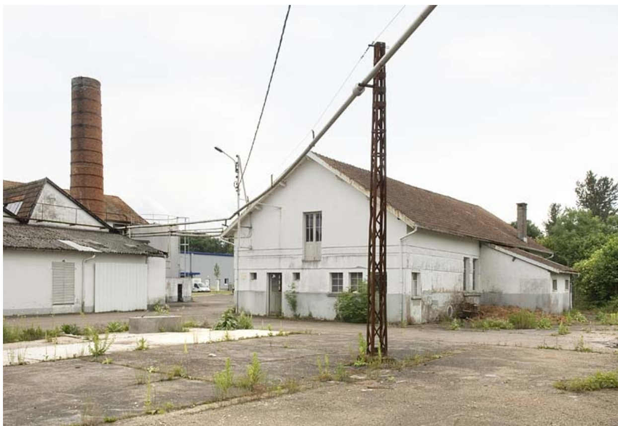
Cheminée et garage à camions.
