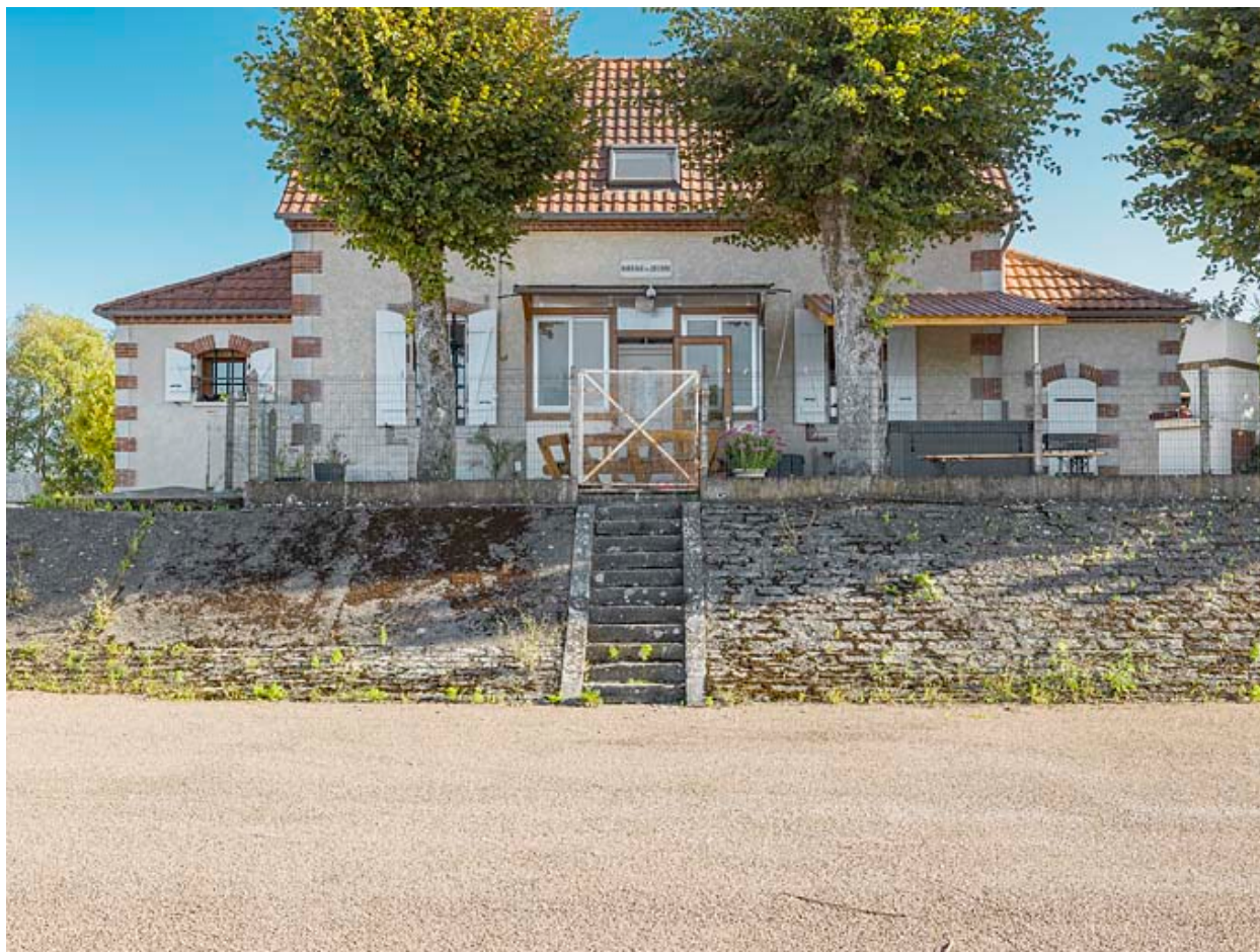
Vue d'ensemble de la maison du barragiste.
