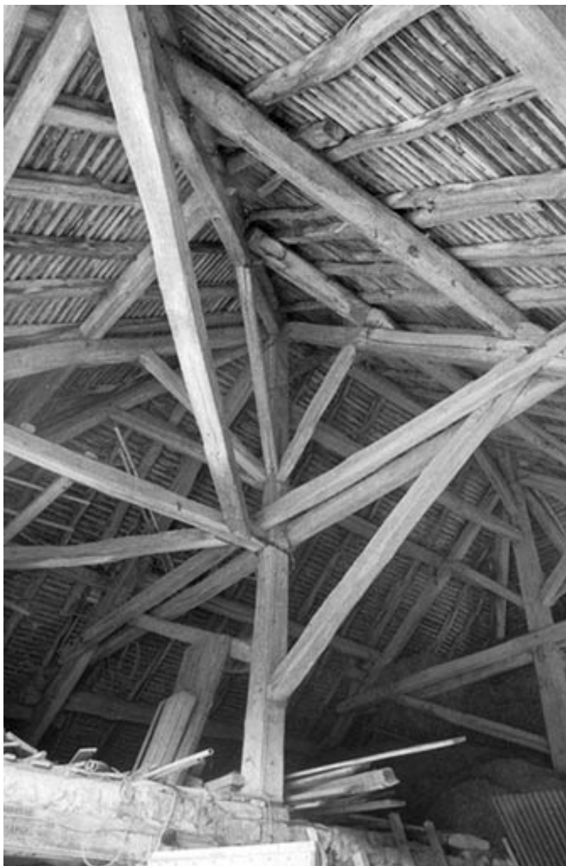
Charpente de la dépendance.
