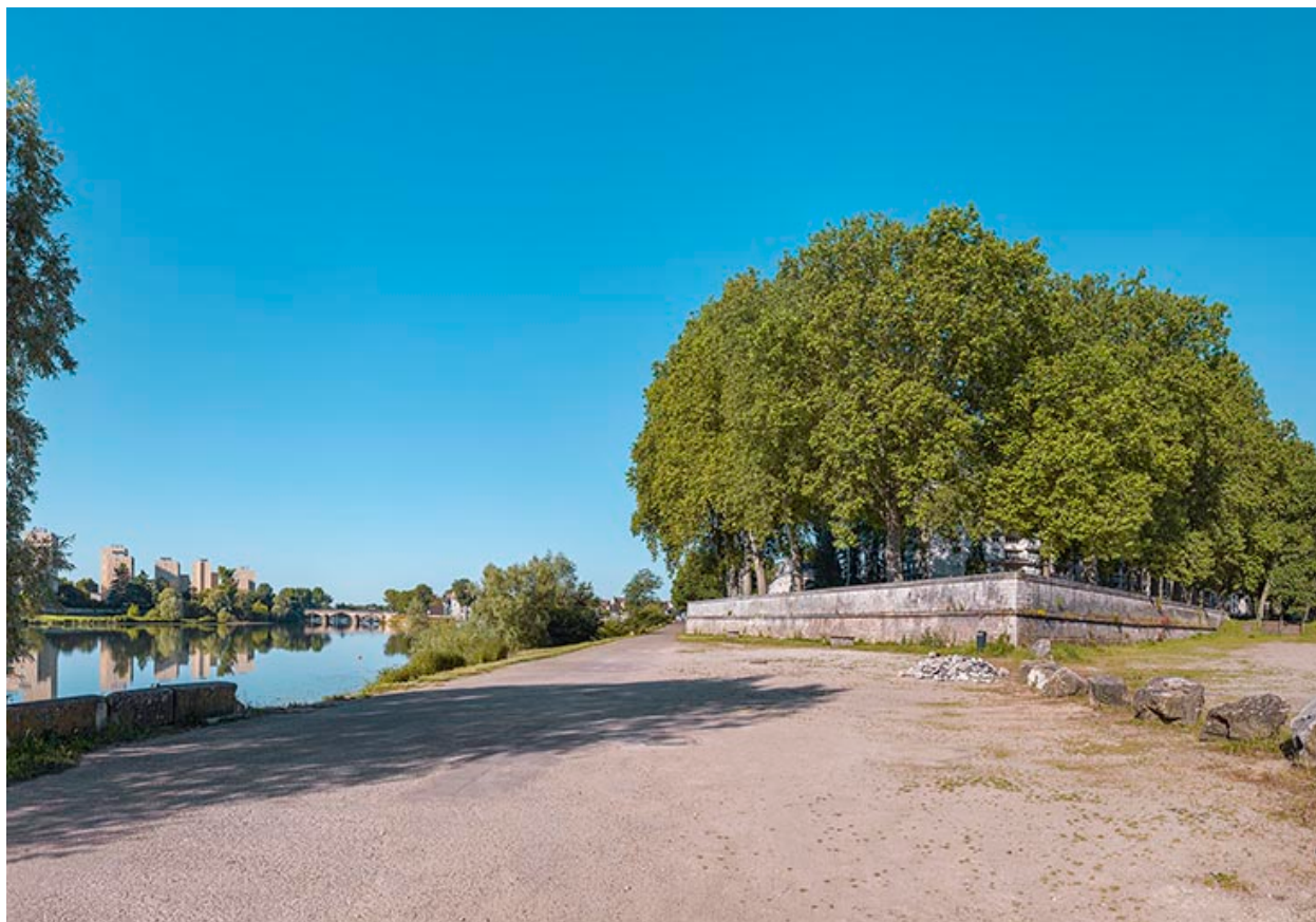
Le bastion, vue depuis l'amont.
