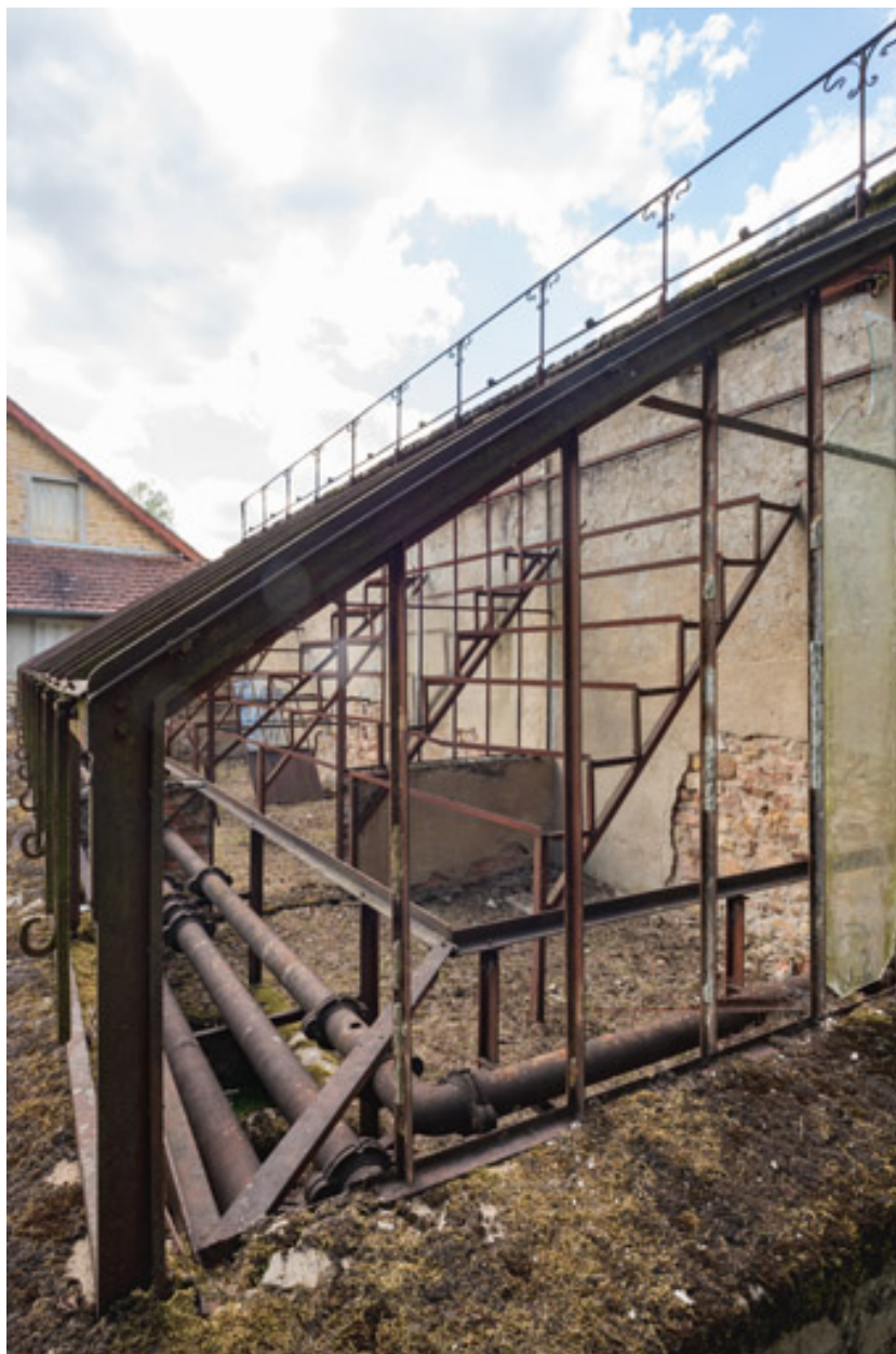
Détail des conduites (radiateurs) de l'ancien chauffage à thermosiphon.
