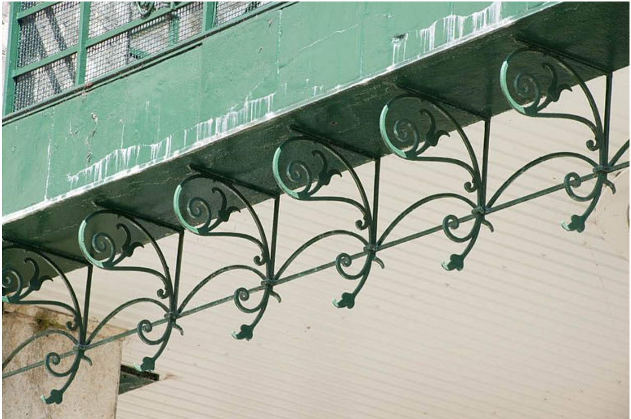
Passerelle sur la façade postérieure. Eléments de décor en fer forgé.
