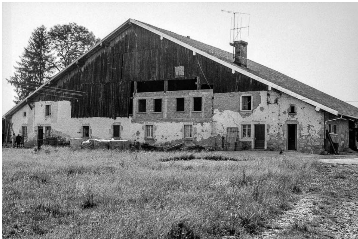
Ferme cadastrée 1938 E 266-267 : façade antérieure.
