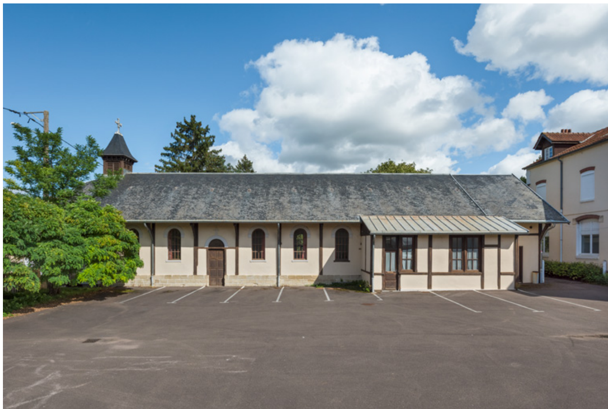
Façade ouest. Vue d'ensemble.
