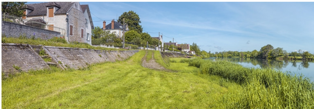
Escalier et digue en aval du ponceau.
