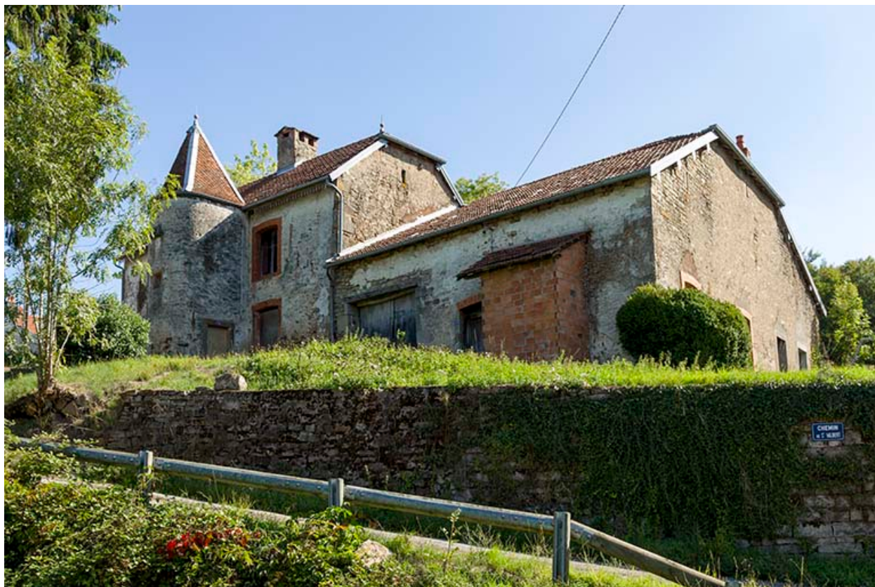
Vue depuis la rue du Moulin.
