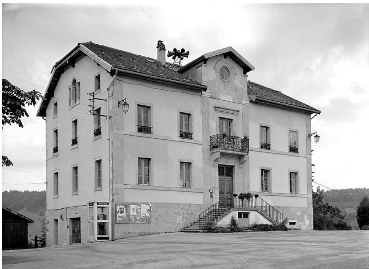
Façade antérieure et face droite.
