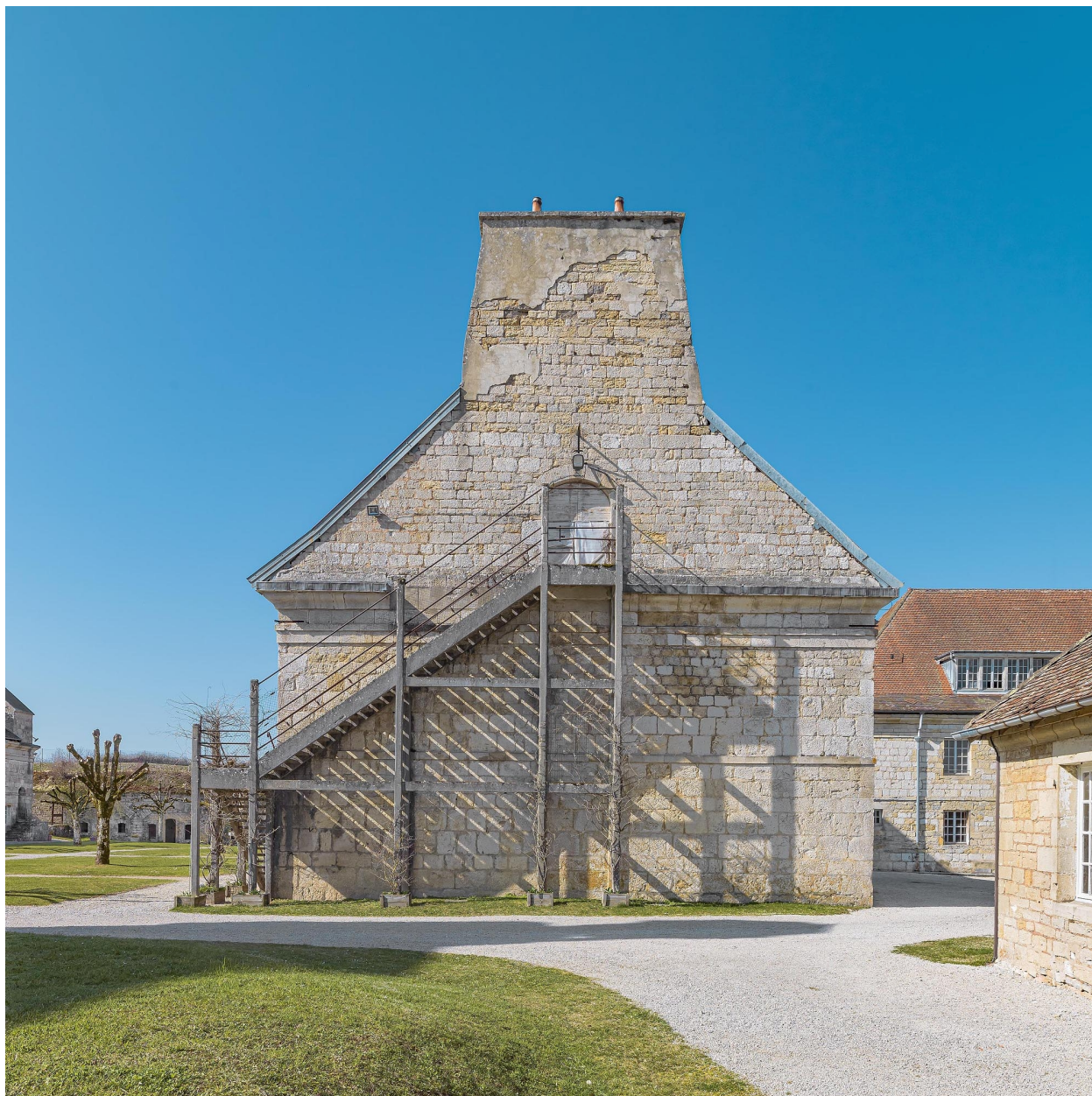
Caserne U : mur pignon est.
