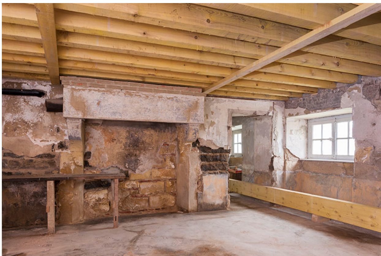
La cuisine du sous-sol et sa cheminée.
