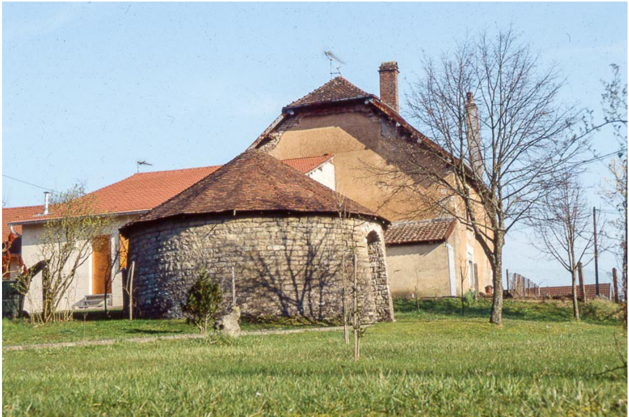
Soubassement en moellon calcaire d'un réservoir à saumure.
