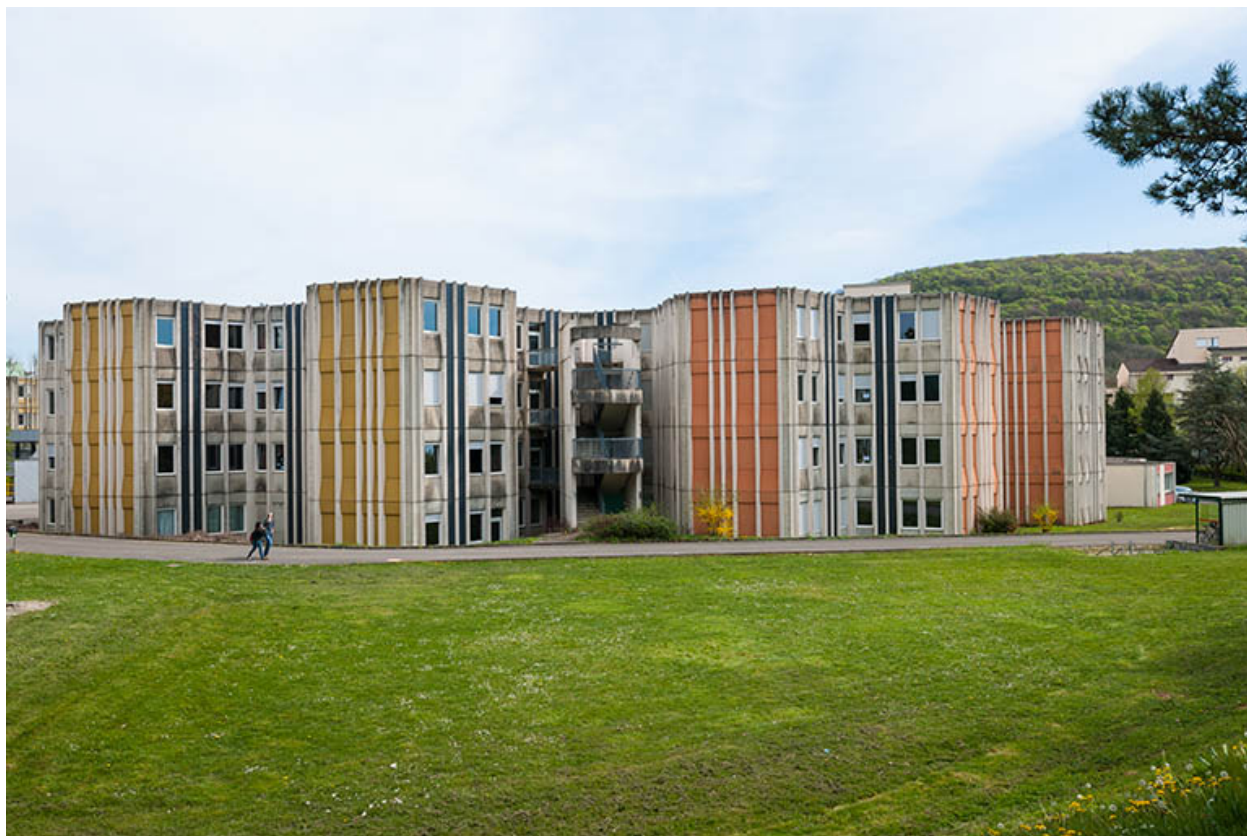
Vue d'ensemble des façades postérieures de l'internat.
