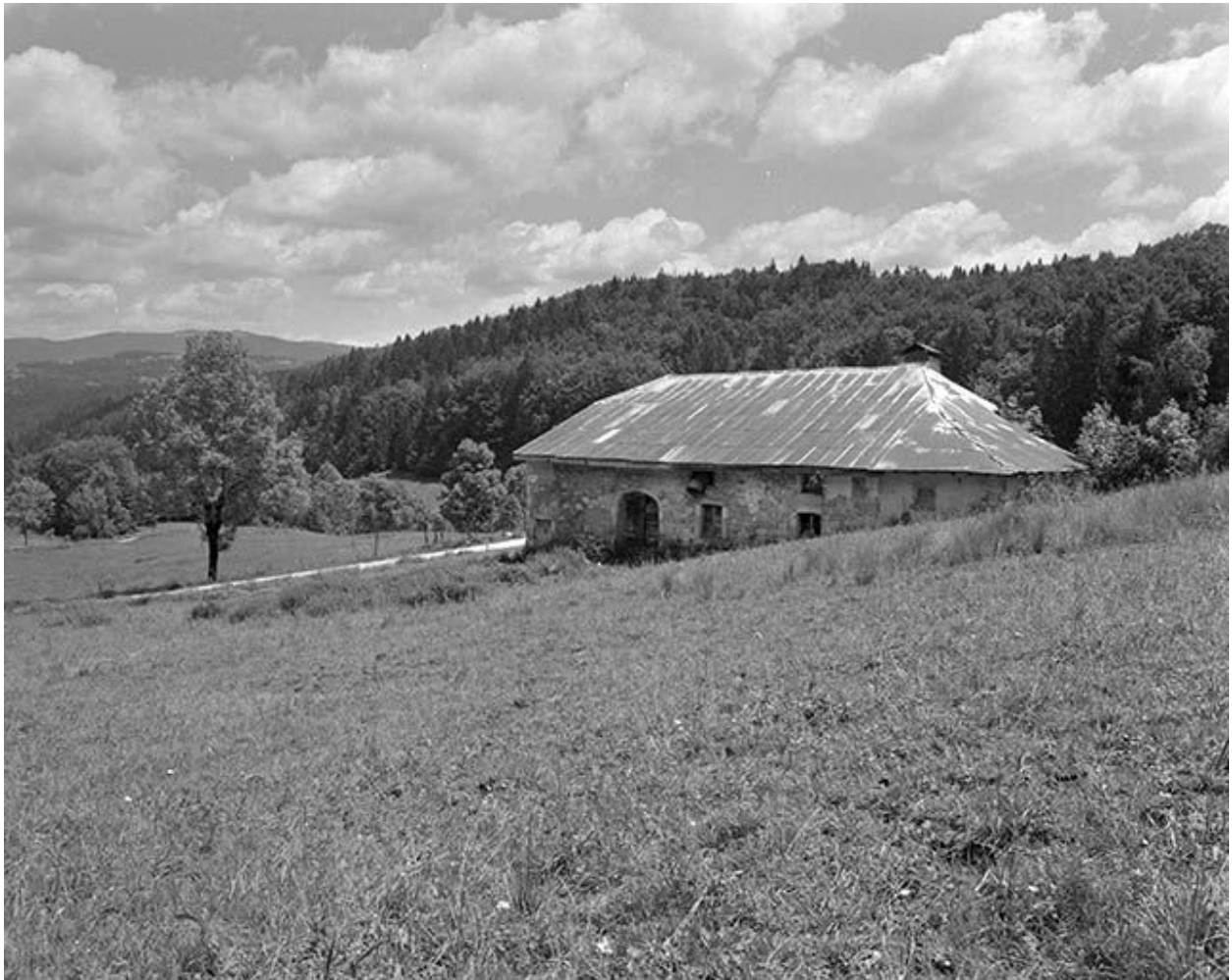
Vue éloignée de la façade postérieure.
