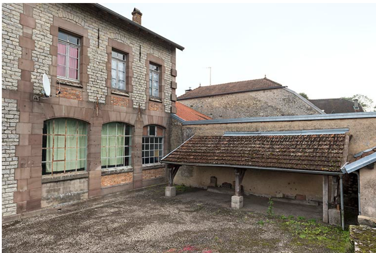
Cour, préau, détail de la façade postérieure.
