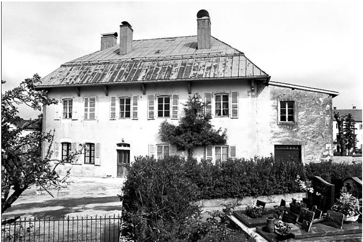
Façade antérieure vue depuis le cimetière.
