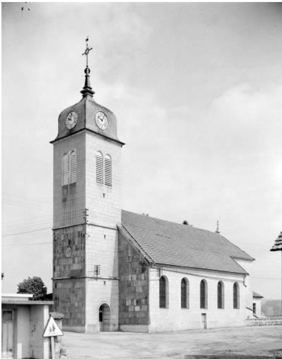
Façade latérale droite.
