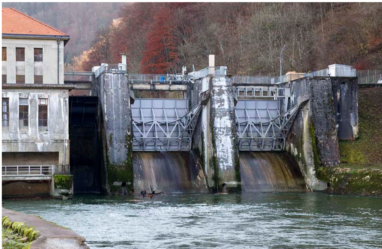
Le barrage vu de l'aval.
