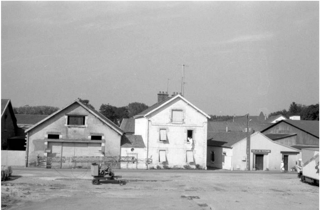
Façade antérieure des écuries et magasins industriels.
