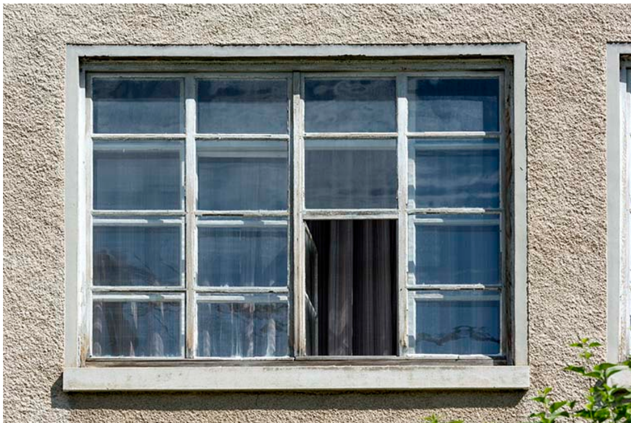
Façade sud : fenêtre d'atelier.
