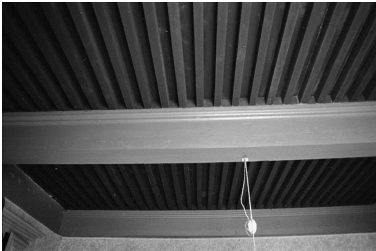
Intérieur : plafond de la cuisine.
