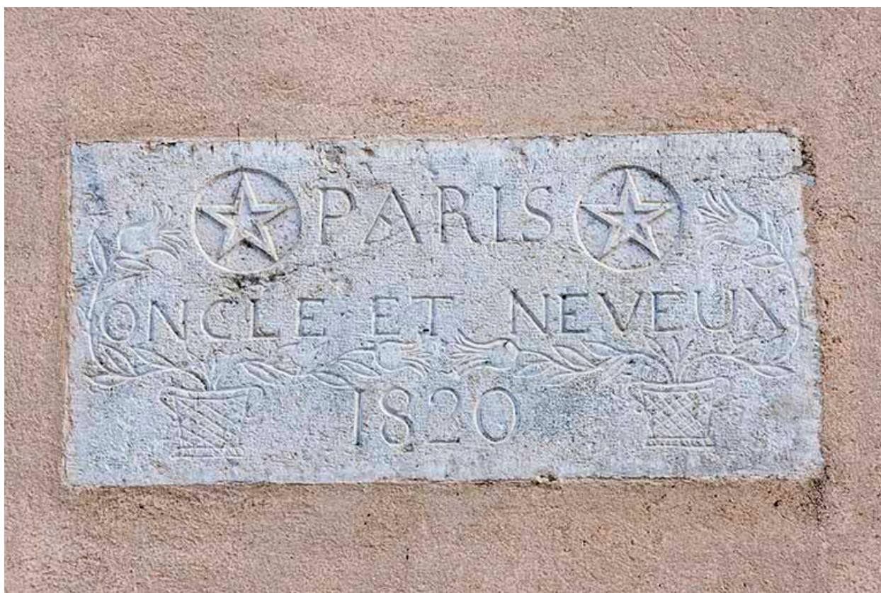
Pierre gravée sur la façade nord.
