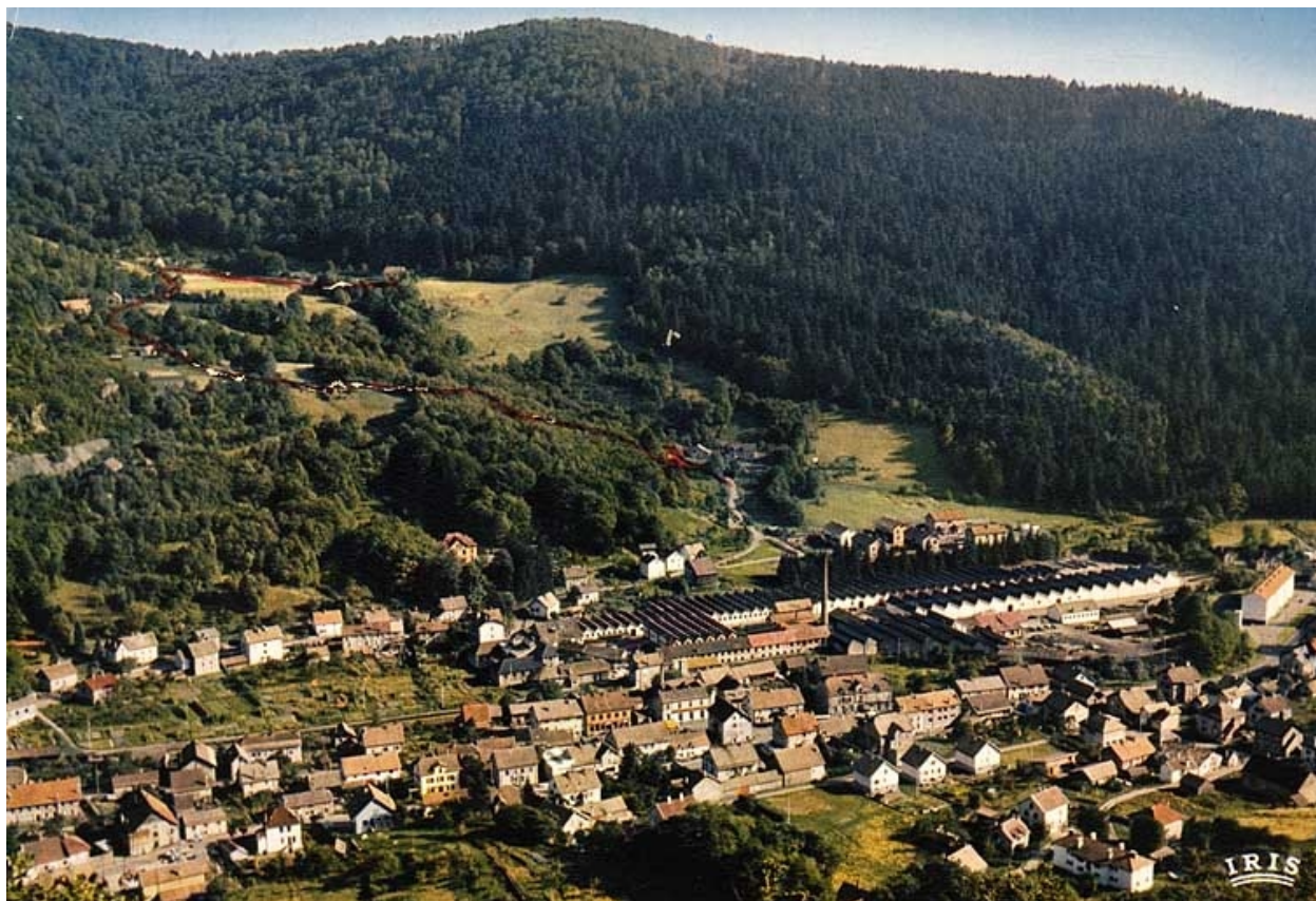
Plancher-les-Mines (Haute-Saône). Vue générale.
